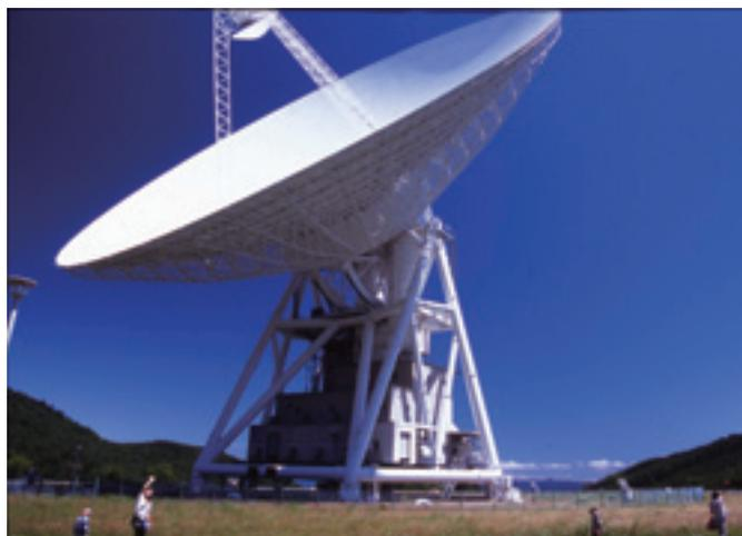
臼田宇宙空間観測所は、深宇宙探査機に向けて動作指令を送信したり、探査機からの観測データを受信している。施設の中核となるパラボラアンテナは、反射鏡の直径が64mと日本一の大きさを誇る。
